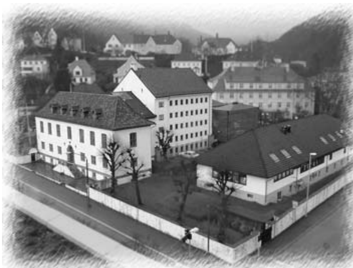
Statsarkivet og konserveringsbygget. Foto: Steffen Ekerhovd
