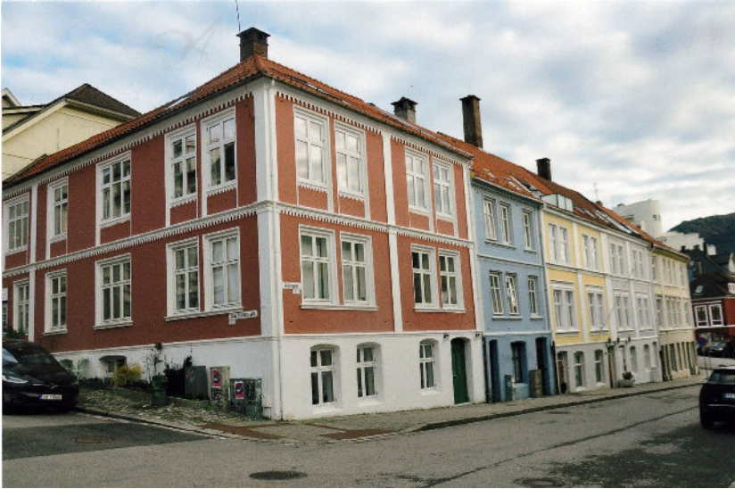
Skottegaten 7 i Bergen der familien Pihl bodde i første omgang da de ankom byen mellom de sju fjell. Vi ser vanntårnet på Nordnes i bakgrunnen. Foto: GAS. Disse murhusene i Skottegaten ble bygd på 1880-tallet. Nr. 7 til venstre.
