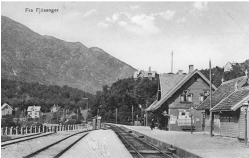
Fjøsanger stasjon. Lånt av John Fredriksen
