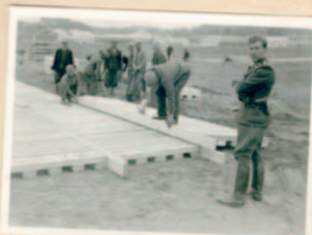
Verbindung dreier Bohlentafeln
